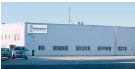
Die neue Lagerhalle in Overath
